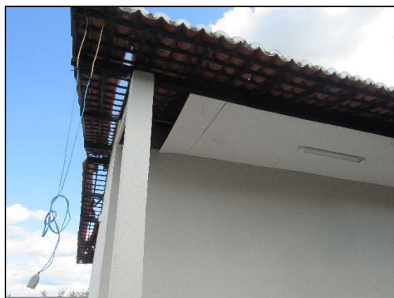
Imagem 12 e 13 – Pontos necessários para retelhamento
